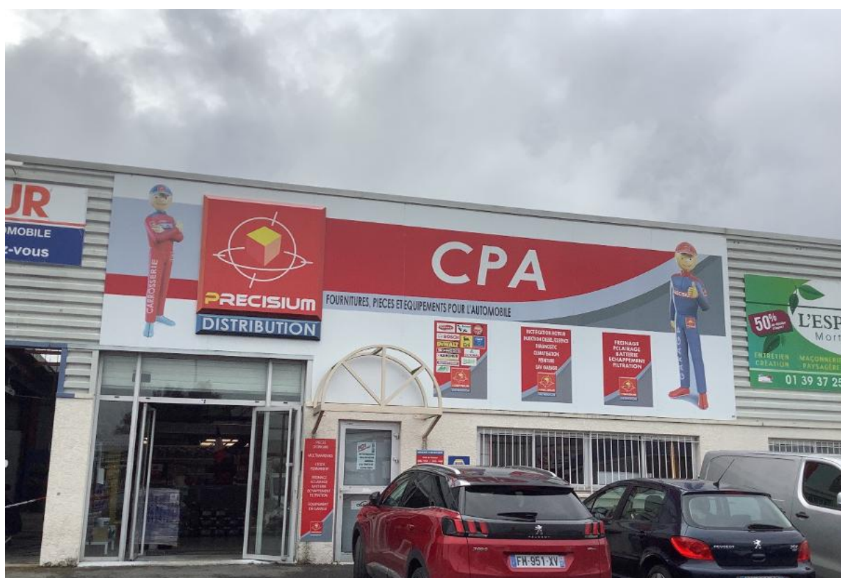
Devanture commerciale dépassant à priori le seuil de surface cumulée d'enseignes sur façade, Chambly, mai 2024
