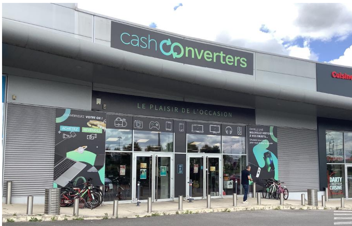
Devanture commerciale dépassant à priori le seuil de surface cumulée d'enseignes sur façade, Chambly, mai 2024
