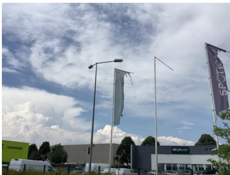
Enseignes en mauvais état d'entretien, Chambly, mai 2024
