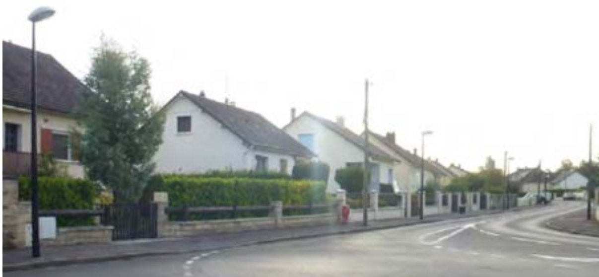
Lotissement pavillonnaire, source : rapport de présentation du PLU de Chambly
