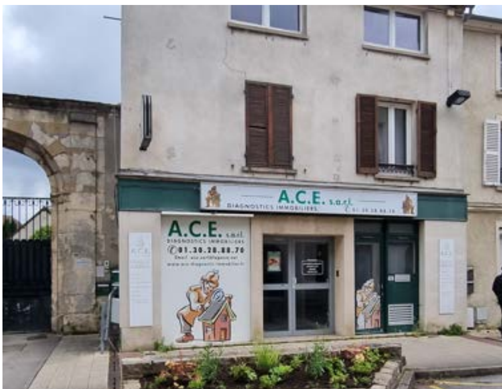
Devanture commerciale dépassant à priori le seuil de surface cumulée d'enseignes sur façade, Chambly, mai 2024
