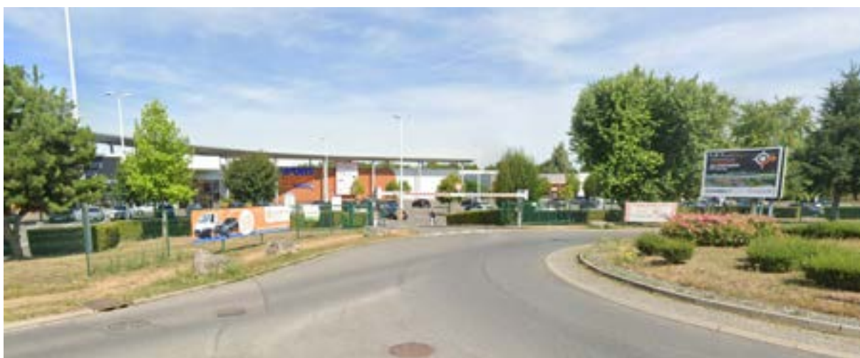
ZA des Portes de l'Oise, source : Google Maps
