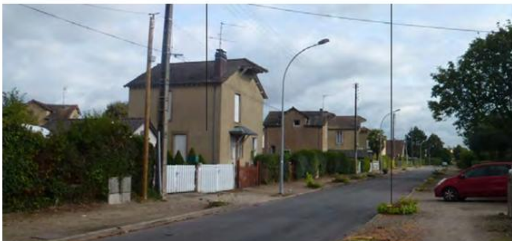
Quartier du Moulin Neuf, source : rapport de présentation du PLU de Chambly
